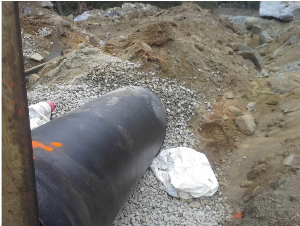
Figur 23: Tverråne kraftverk ca 200 meter opp for kraftstasjonen, nedfylt rørgate, tilsynelatende med pukk rundt hele eller store deler av røret. (Foto: Tor Oxhøvd Svalesen)
