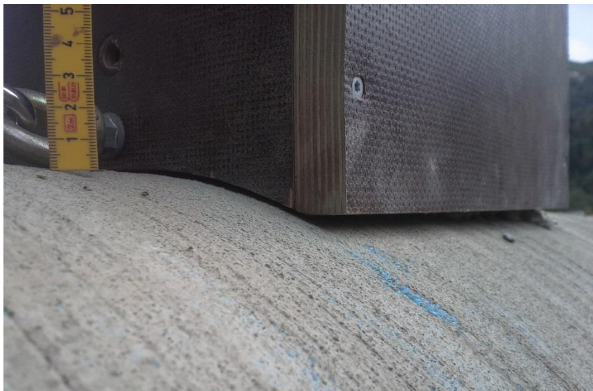
Figur 55:Kasse mot rør med sementmørtelbetong
