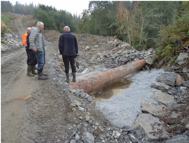
Figur 15: 110 mm drenerør som går fullt etter bekkekryssing. Foto: Tor Oxhovd Svalesen
