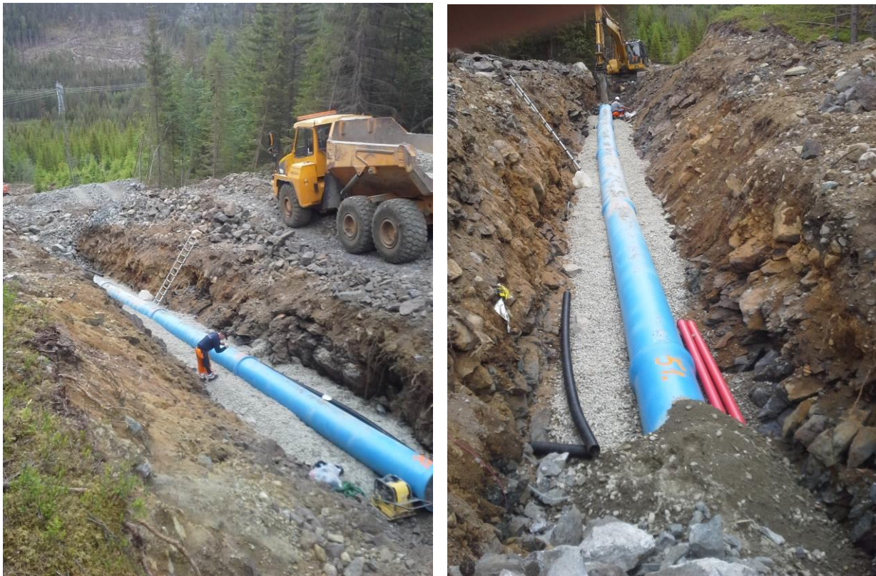
Figur 28: Nybuelve kraftverk, oversiktsbilder bygging av rørgate. Entreprenør i gang med bildetaking og egenkontroll til venstre, graving av grøft til høyre.. (Foto Tor Oxhøvd Svalesen)
