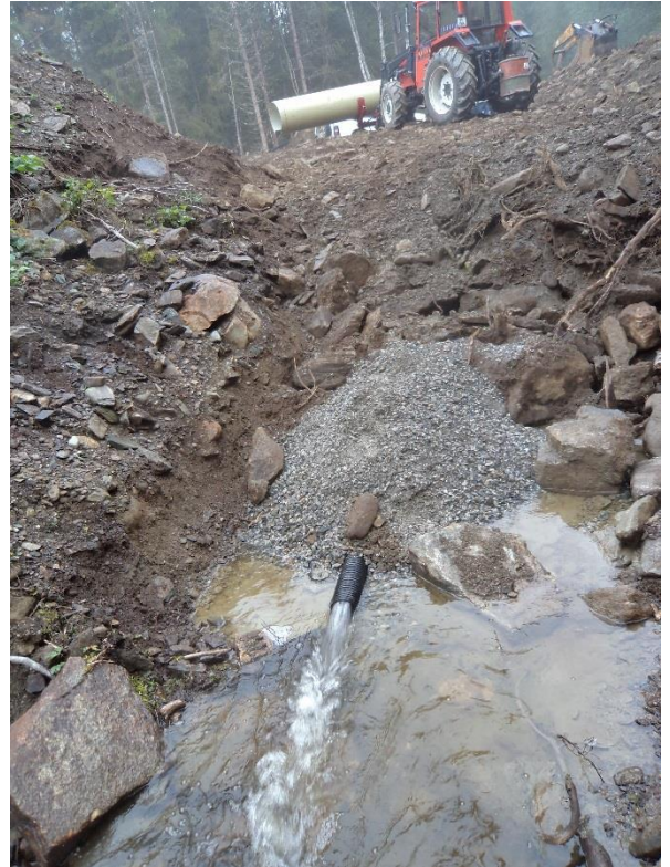
Figur 15: 110 mm drenerør som går fullt etter bekkekryssing. Foto: Tor Oxhovd Svalesen
