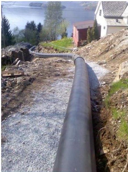
Figur 9: Fleksible montasje-muligheter med PE-rør (Hordaland Rørteknikk AS)
