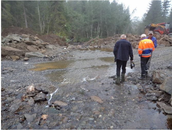
Figur 14: Bekkekryssing Sundli Kraftverk, foto: Tor Oxhovd Svalesen
