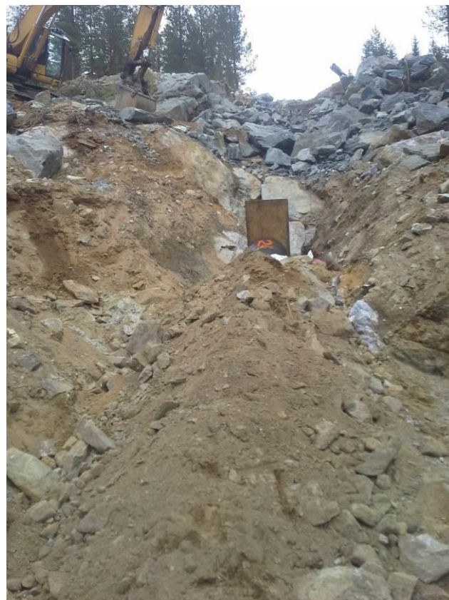
Figur 21: Tverråne kraftverk, nedfylt rørgate ca 200 meter opp for kraftstasjonen. Masseprøve M2 er tatt i dette området. (Foto: Tor Oxhøvd Svalesen)
