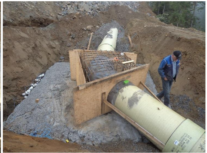
Figur 17: Bend B7. Legg merke til størrelsen på plata i forhold til selve klossen rundt røret. Foto: Tor Oxhøvd Svalesen
