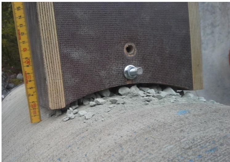
Figur 56: Oppløft av kasse på grunn av momentkrefter fra trekkraften i sylindringen
