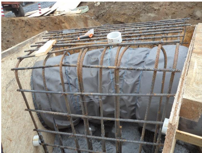
Figur 18: Armering av bend B7 (30°). Inn mot røret er det lagt en duk som skal hindre at betongen hefter direkte i GRP-materialet. Foto: Tor Oxhøvd Svalesen
