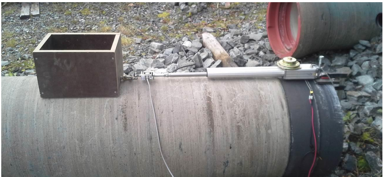
Figur 45: Sylinder og kasse montert på sementmørtelbetong-rør
