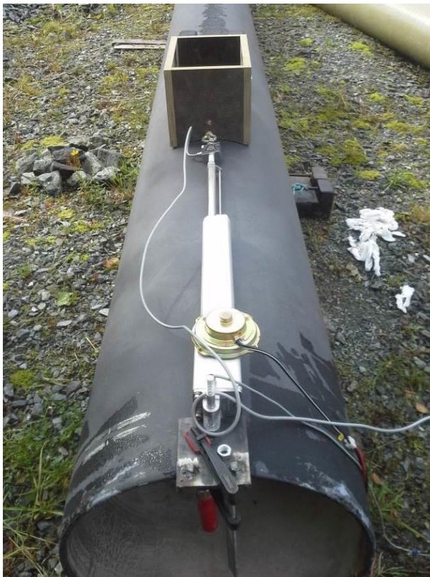
Figur 44: sylinder og kasse montert på sink/bitumenrør
